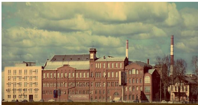
Рисунок 44. ЛМЗ – Советское и российское энергомашиностроительное предприятие, проектирующее, изготавливающее и обслуживающее паровые, гидравлические и газовые турбины различной
