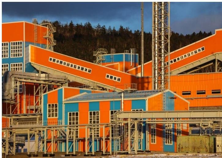
Рисунок 133. Сахалинская ГРЭС. Тепловая электростанция мощностью 120 МВт, расположенная на острове Сахалин вблизи с. Ильинское Томаринского района. Построена с целью увеличения общей мощности энергосистемы острова с учетом обеспечения потребностей перспективного развития экономики
