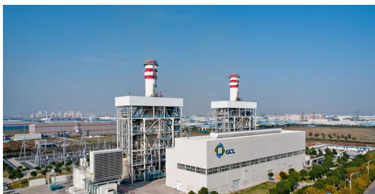
Рисунок 118. Тепловая электростанция г. Ляоюань (пров. Цзилинь, КНР)
